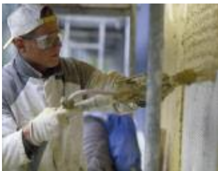
Bild 3: Montage eines WDVS mit dickschichtigem mineralischem Kratzputz
